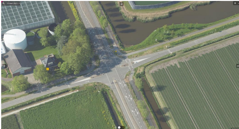
Figuur 3.2 Luchtfoto kruising (bron: Streetsmart 2024)
