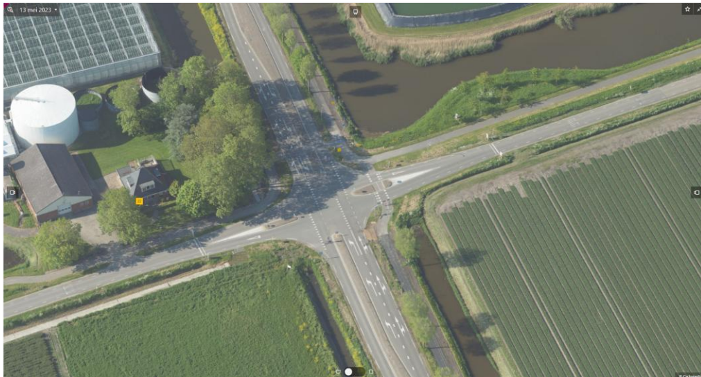
Figuur 4 Luchtfoto kruising (bron: Streetsmart 2024)
